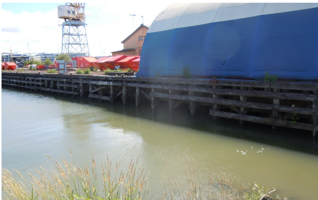
Figur 9 Betong- och träkaj på den västra sidan av hamnbassängen.
