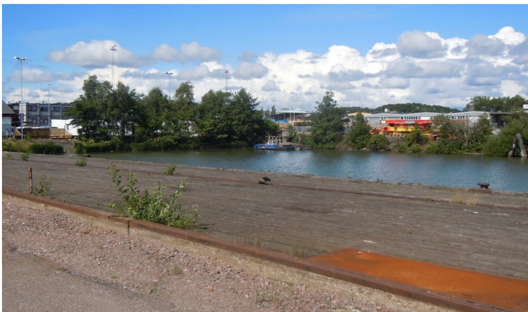
Figur 3 Betongkaj med kranbana på västra sidan av hamnbassängen.
