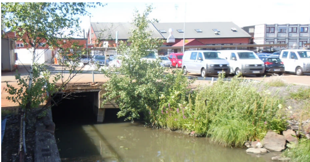
Figur 5 Dagvattenkanal och den norra delen av hamnbassängen som fylldes ut i början av 1980-talet.
